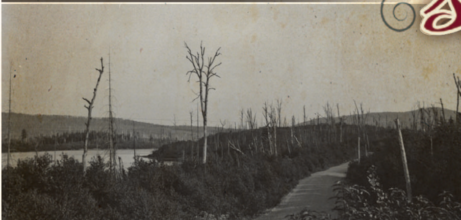
La seule photo connue du feu près d'ici datant probablement de 1903 ou peu après. Les suites de l'incendie dans le secteur du comté de Montcalm, sis au sud de Sainte-Marguerite. BANQ 03Q_E6S7SS1P79820
